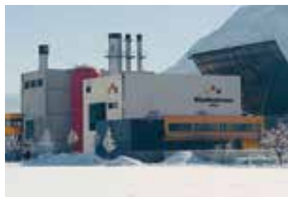
Heizwerk der Stadtwärme Lienz
