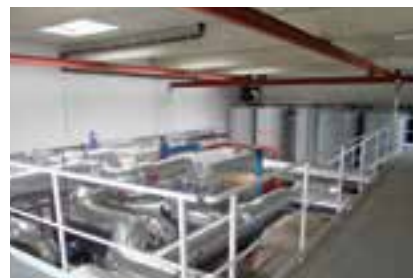
Verrohrung großes Kesselhaus
